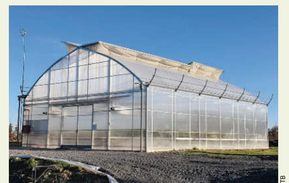
Les premiers essais pour lutter contre les pucerons sont mis en place depuis l'automne 2020.
